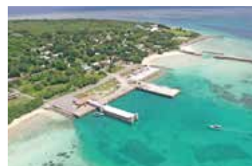
■ドローンによる現況調査
