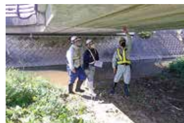
■橋梁定期点検状況
