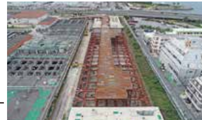
■那覇浄化センター整備事業
