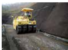
道路工事におけるリサイクル品利用 (再生路盤材の使用)
