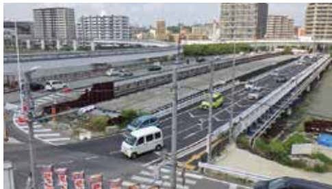
■那覇内環状線(那覇大橋)整備事業
