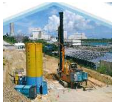
施工例(イメージ図) セメント系固化材
