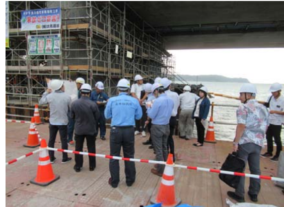
写真2 現場視察状況①
