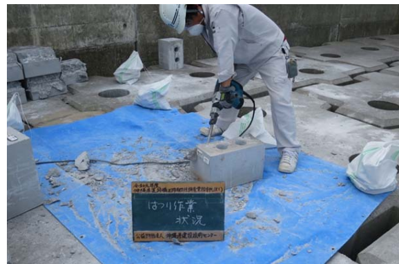
写真 2 現場調査状況（はつり状況）
