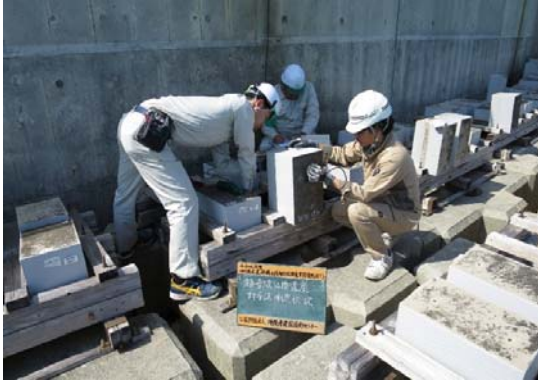
【現場調査状況】
