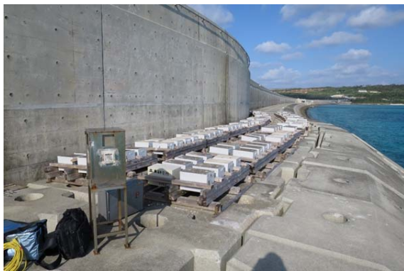
写真 1 伊良部大橋暴露試験場
