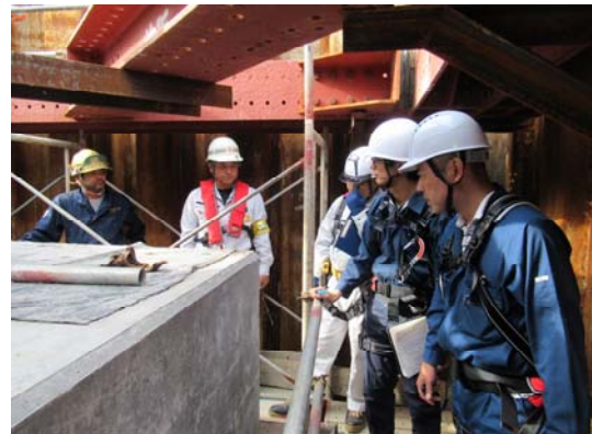
写真2 下部工フーチング表層確認状況
