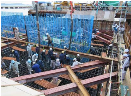
【フーチング打設立会状況】
