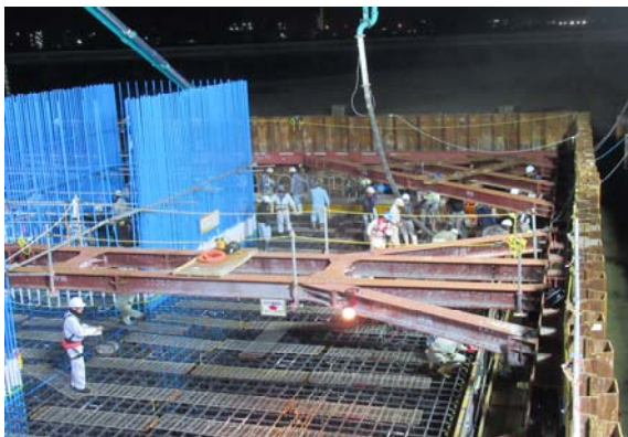
写真1 下部工フーチング打設状況
