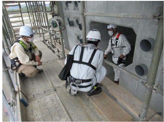
写真-14 P9 柱頭部 表層品質確認状況
