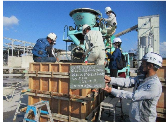
写真-10 疑似断熱温度上昇試験打設状況
