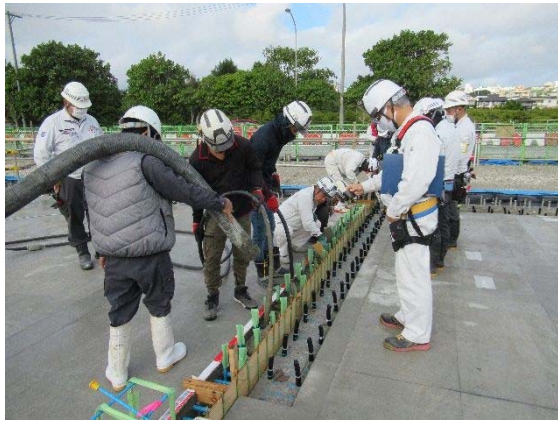
写真-13 張出床版(A1-P1 間)打設立会状況
