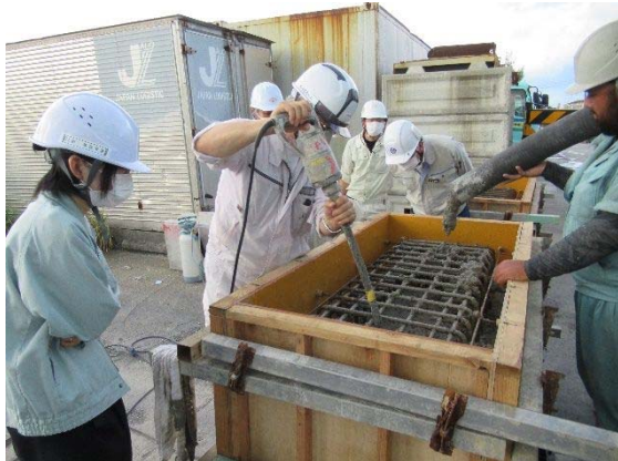
写真-9 打設試験状況
