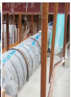
施工例(イメージ図) 埋設管の受け防護
