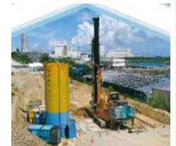
施工例(イメージ図) セメント系固化材
