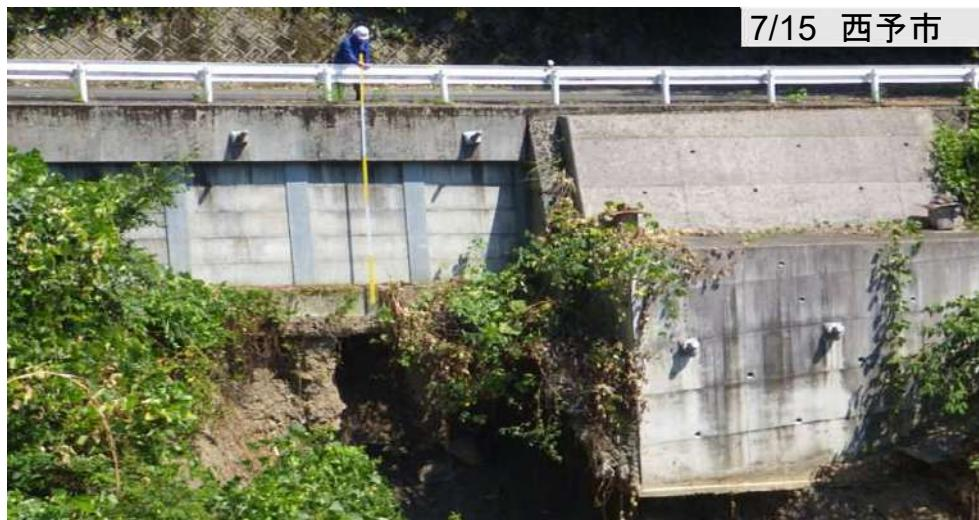
大雨によって崩落した擁壁下の斜面を調査
