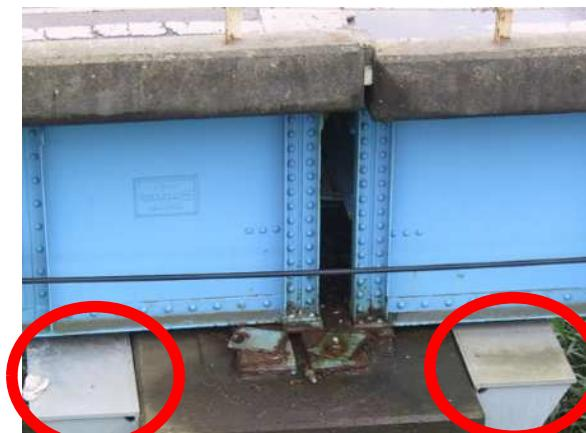
【支承補強(変位制限構造)】
