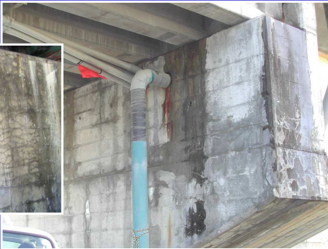
亀甲羅状のひび割れが見受けられる
