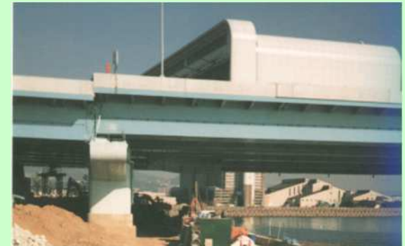
写真. 流動化による橋脚基礎の変位(兵庫県南部地震)
