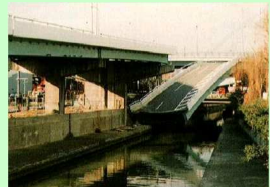
写真. 曲線橋の落橋(兵庫県南部地震)
