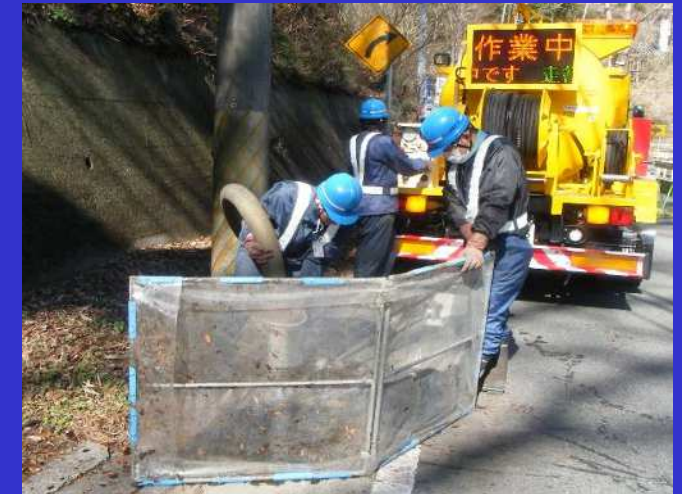
(側溝清掃作業)
