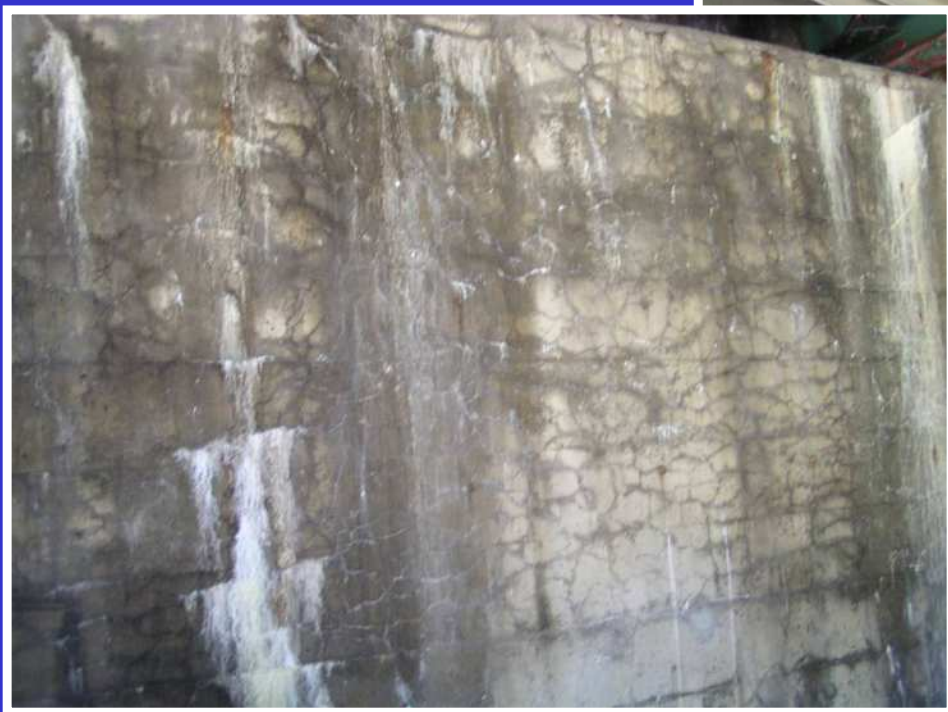
亀甲羅状のひび割れが見受けられる
