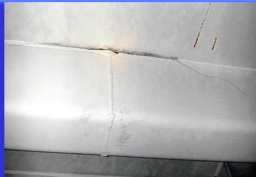
鋼床版縦リブとデッキプレートの継手部
