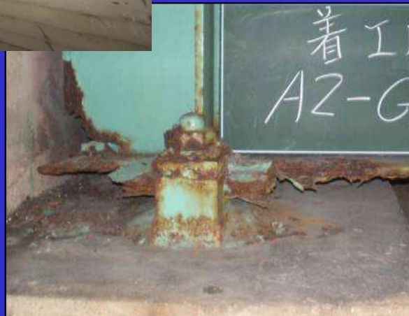
鋼材の腐食
