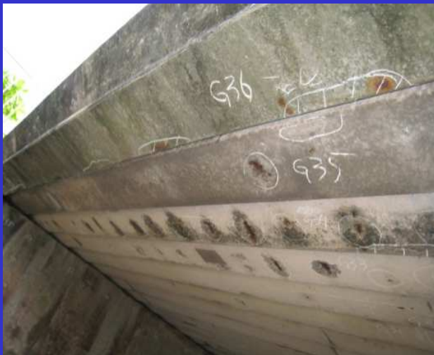
コンクリート剥離(塩害)
