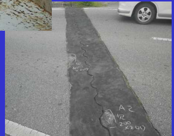
伸縮装置の破損
