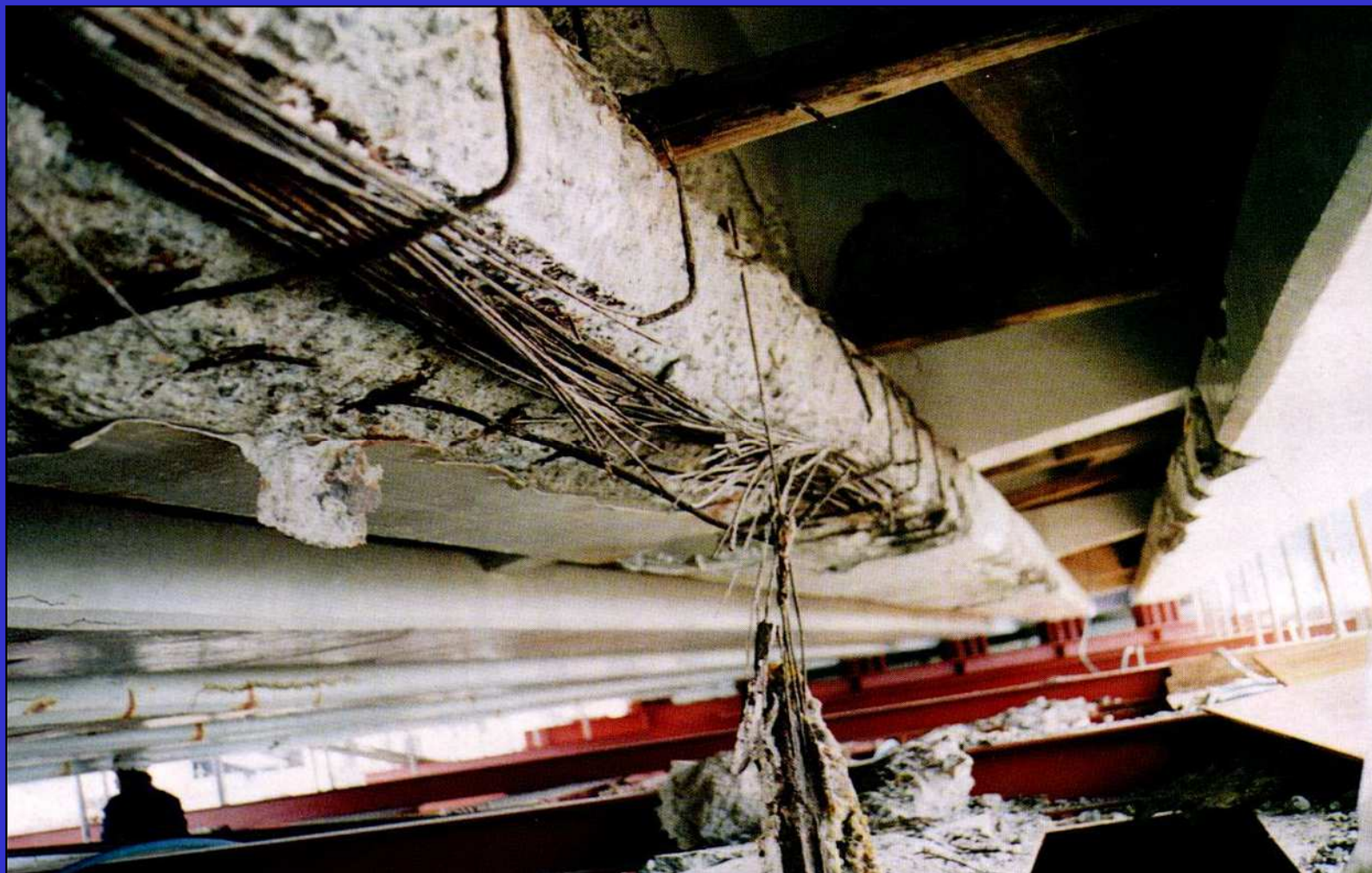
PC橋梁の老朽化によるPC鋼線の破断
