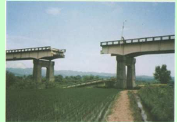
写真. ゲルバー桁橋の落橋(宮城県沖地震)
