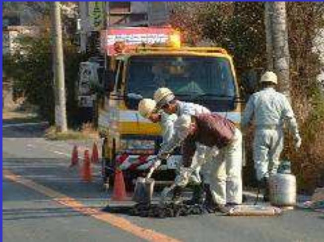
(路面補修作業)
