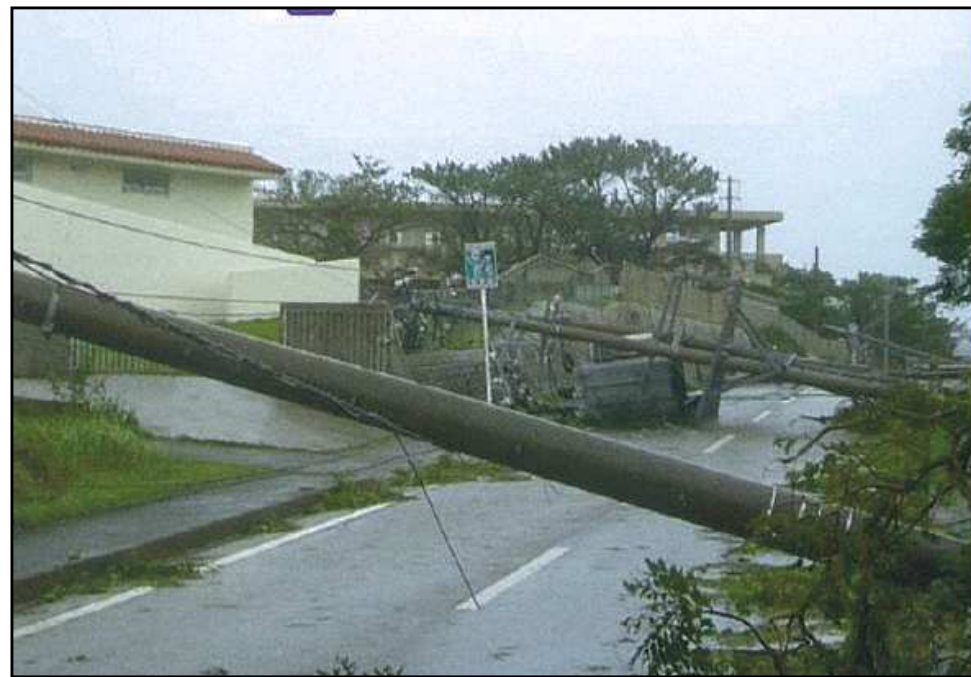
平成18年 台風13号で倒壊した電柱(石垣市)
