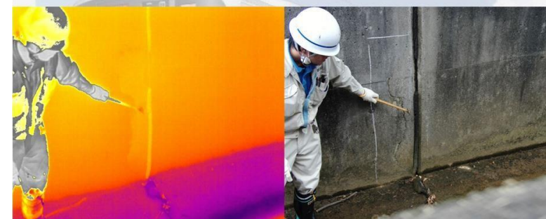
温度の高い箇所と浮きの発生箇所が概ね一致した
