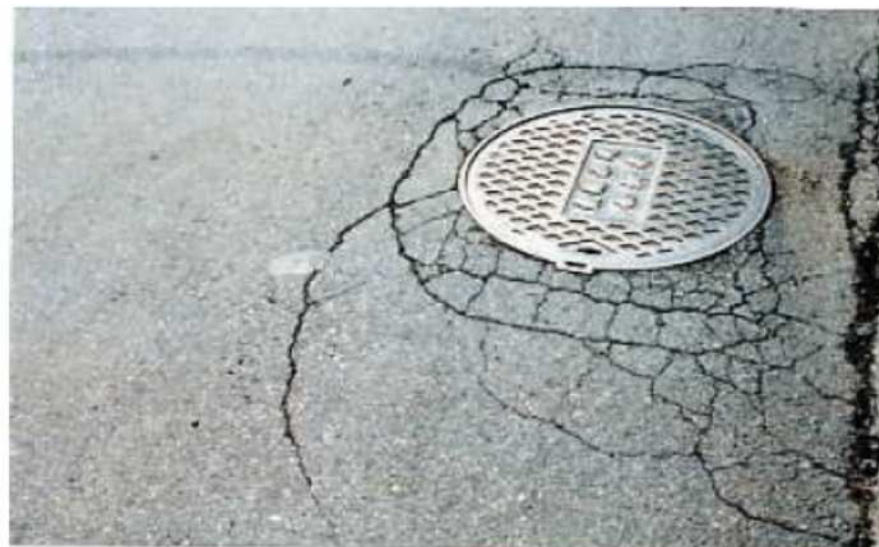
構造物に起因するひびわれ
