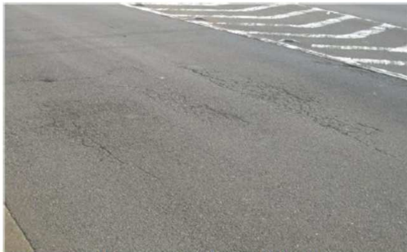
沈下によるひびわれ
