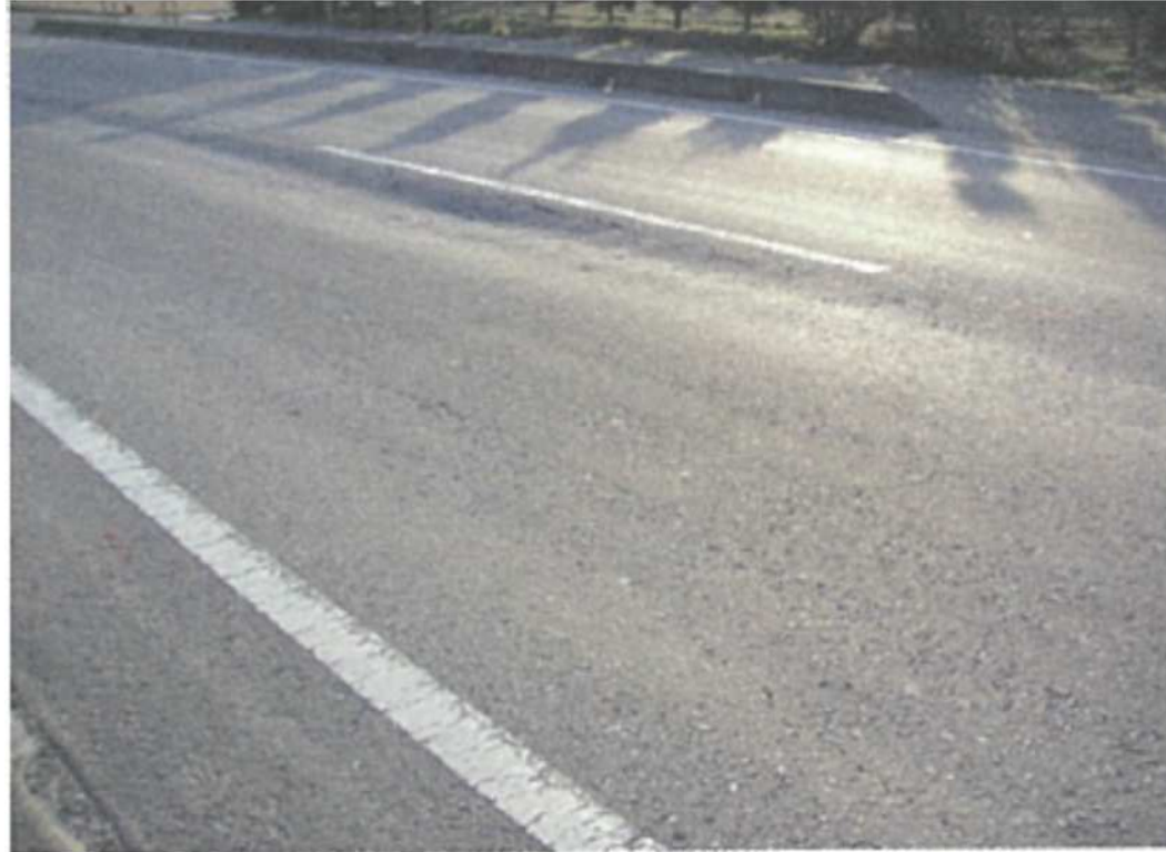
沈下わだち掘れ
