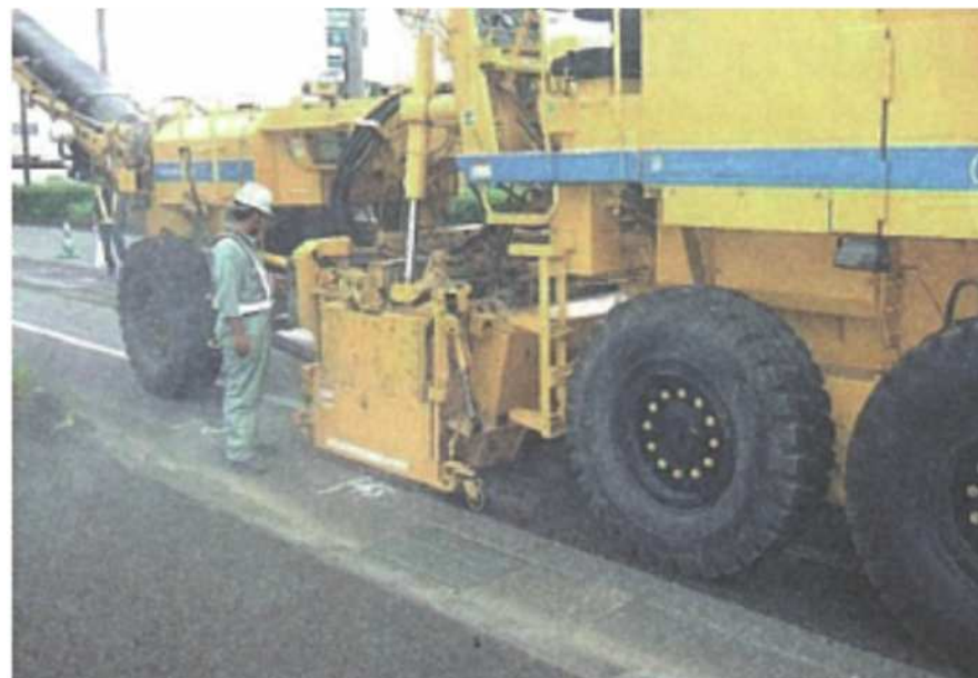
路面切削機による切削状況
