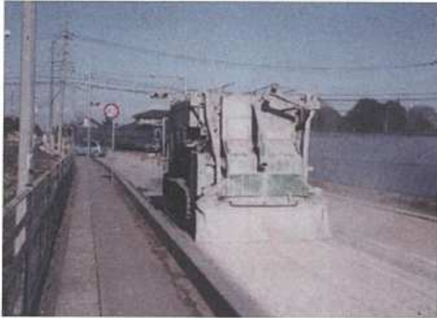
セメントの機械散布状況
