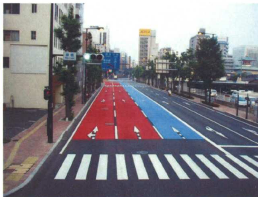
写真6 車線誘導の施工事例
