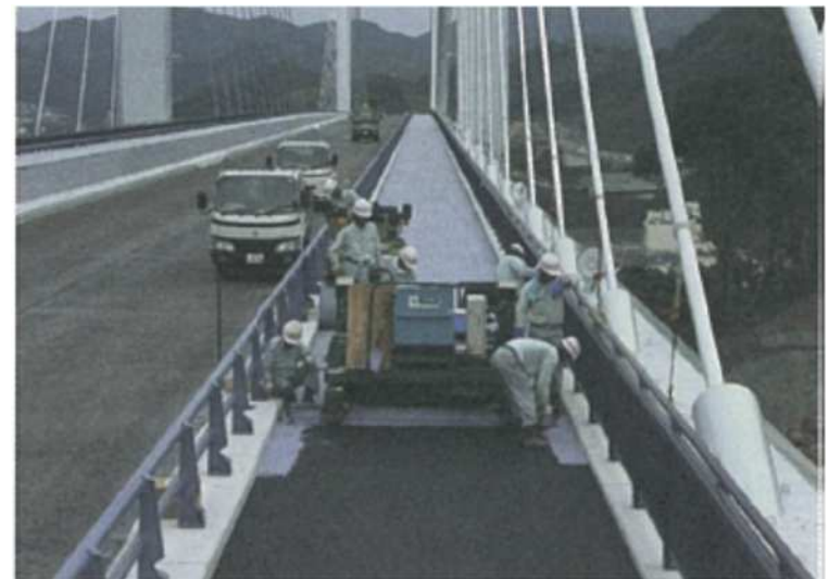
透水性樹脂モルタル充填工法の施工
