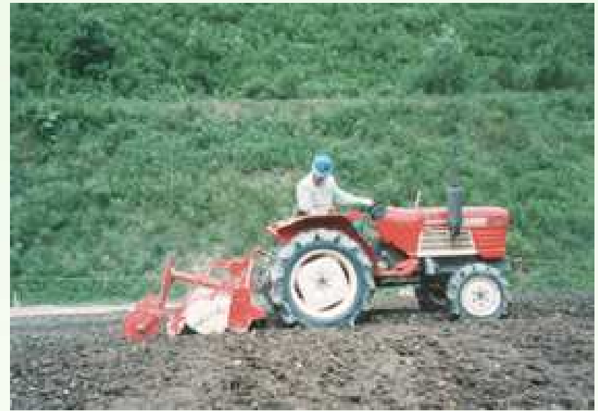
改質材を添加してトラクターで攪拌
