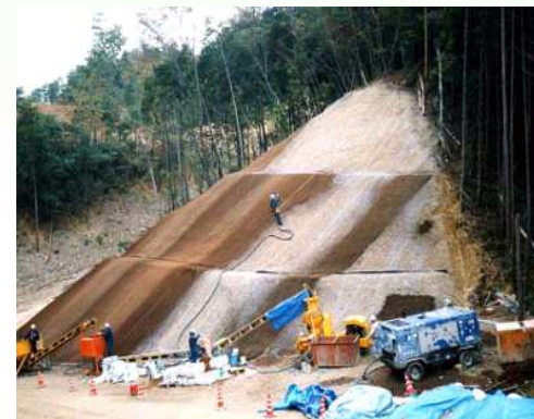
吹付施工状況と吹付後の緑化状況
