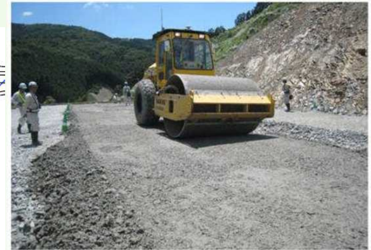
セメント系固化材による不溶化試験施工
