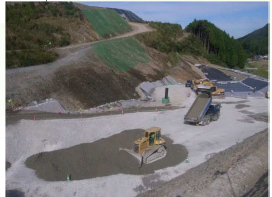
不溶化土による盛土施工状況
