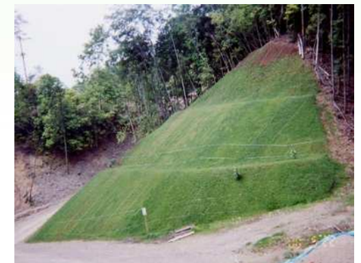
吹付施工状況と吹付後の緑化状況
