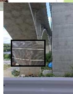
ナットキャップの使用による腐食防止
