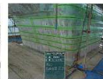
溝切電極設置工
