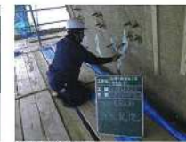
ひび割れ注入工
