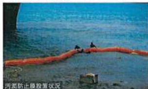
汚濁防止膜設置状況
