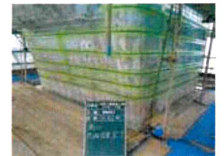
溝切陽極設置工
