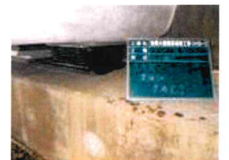
断面修復工(完了)
