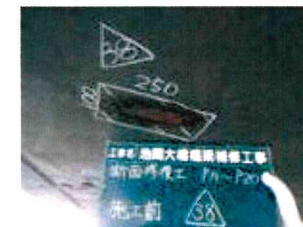
断面修復工(施工前)
