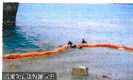
汚濁防止膜設置状況
