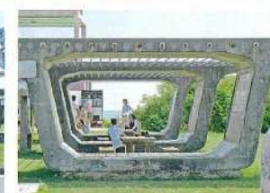
上部工に使用した桁の設置
