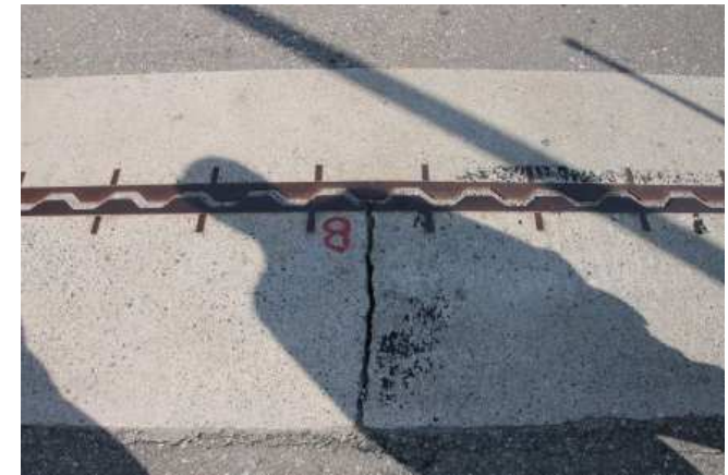
伸縮装置の破断 パラペットの割れ
