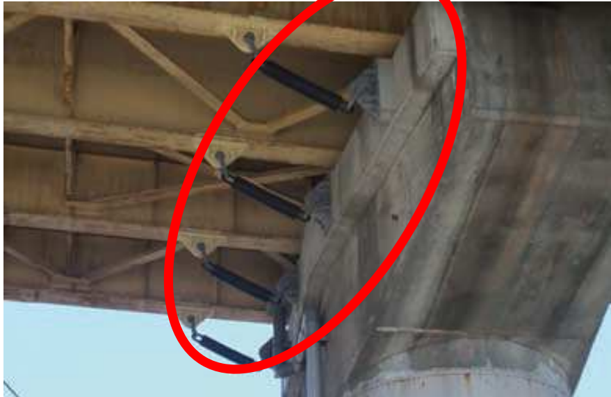
落橋防止装置の設置
