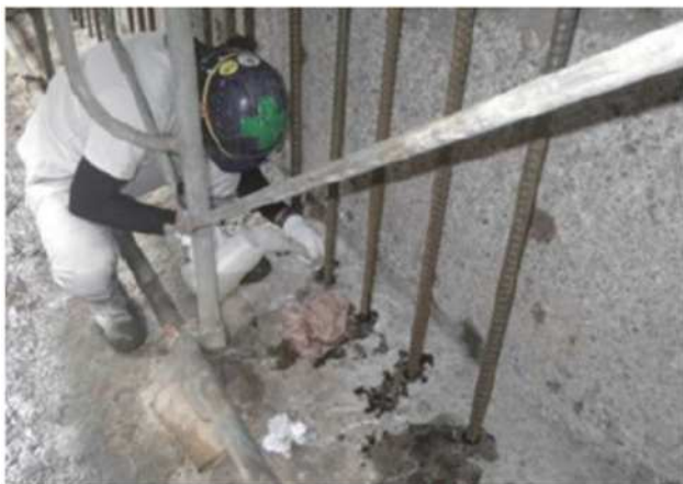
橋脚のコンクリート補強・鉄筋アンカー工
