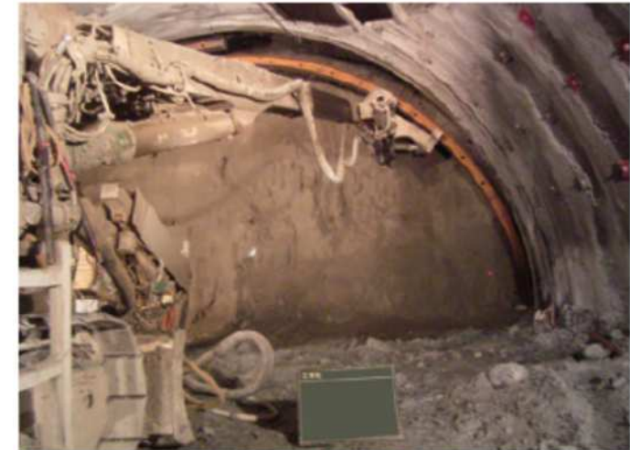
図7 鋼製支保工建て込み状況④
