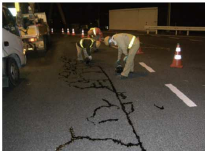
舗装路面クラックのアスファルト溶材注入工事
