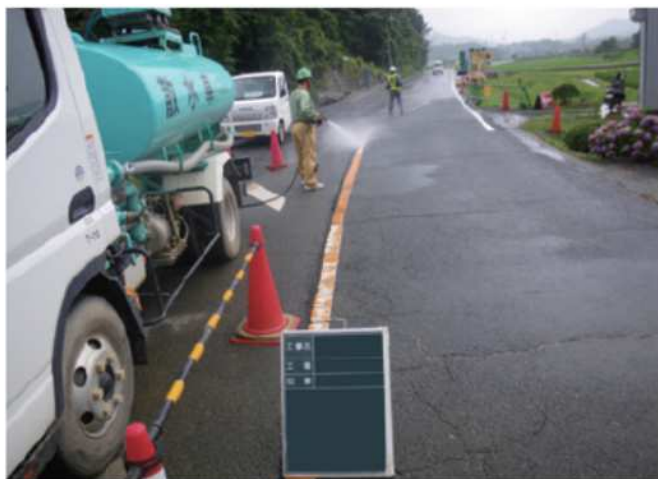
舗装路面の清掃工事
