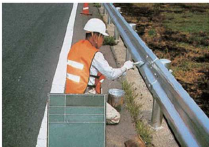
ガードレールの塗装工事
