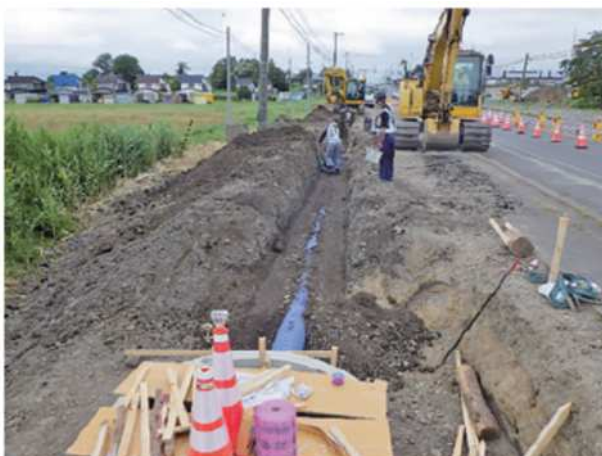
電線・光ケーブル等のさや管設置工事
