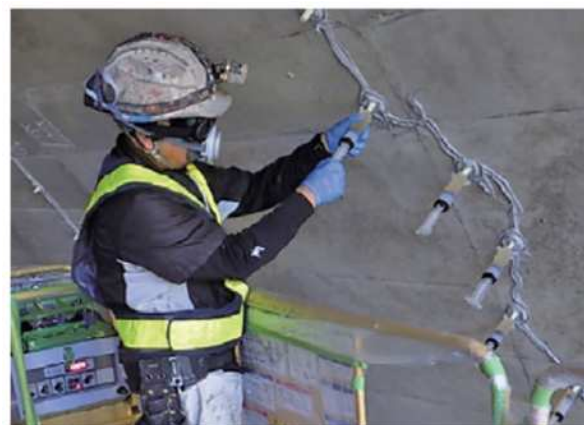
トンネル覆工ひび割れ防止注入工
