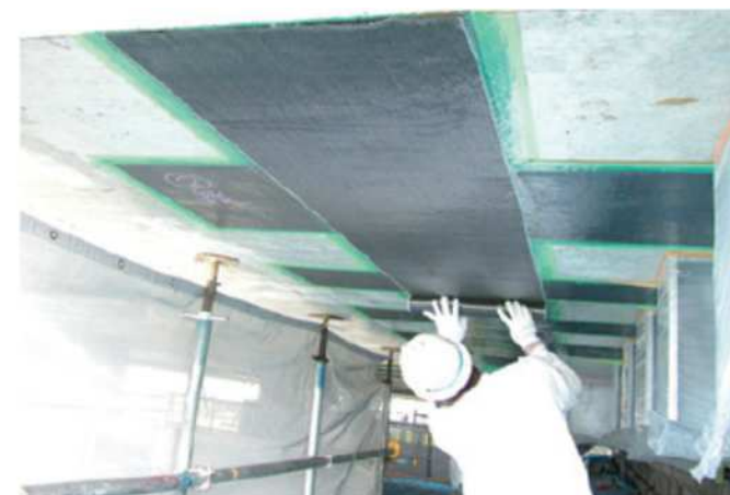
コンクリート床版の炭素繊維シート補強工事
