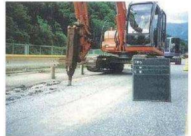
大型ブレーカによる舗装壊し工事
