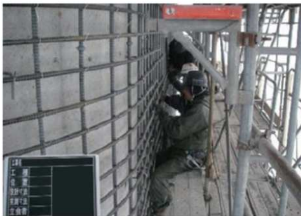
橋脚のコンクリート補強・鉄筋組立工
