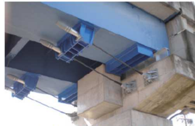
橋脚のPC鋼棒による落橋防止工
