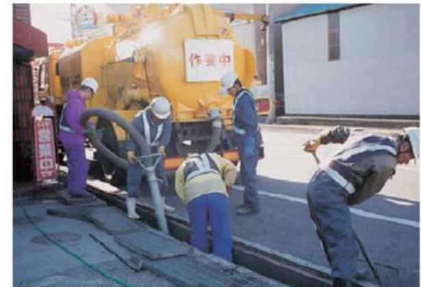
バキューム車による道路側溝清掃作業
