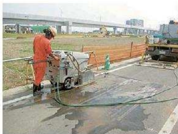
コンクリートカッタ機による舗装路面切断工事
