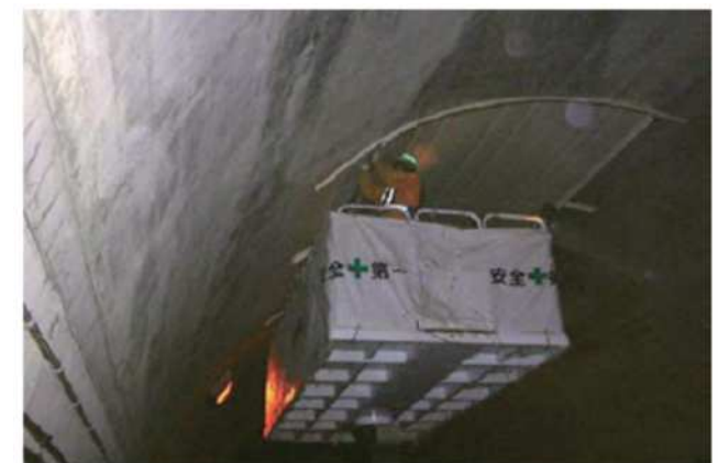
高所作業車による防水板設置作業
