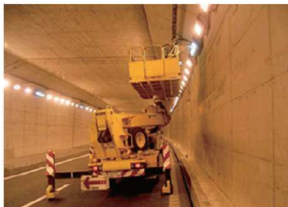
高所作業車によるトンネル照明清掃作業
