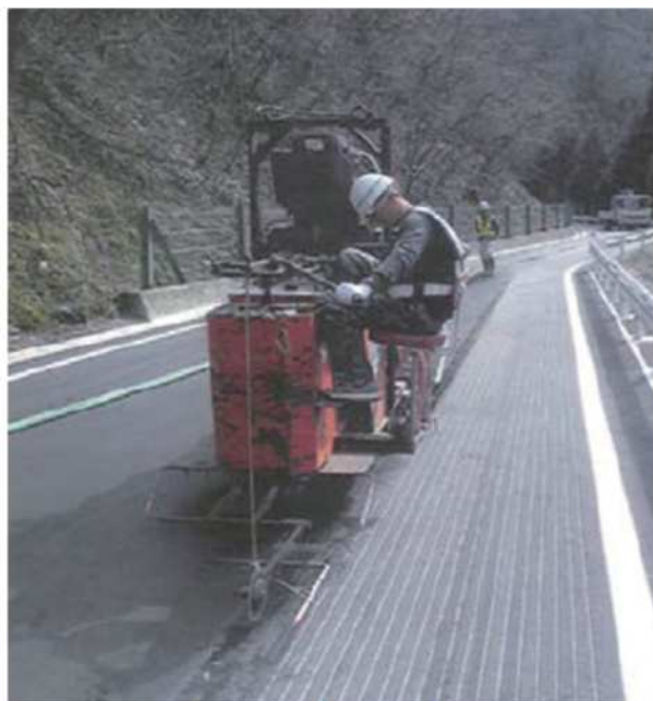
グルーピング工法溝切削工事
