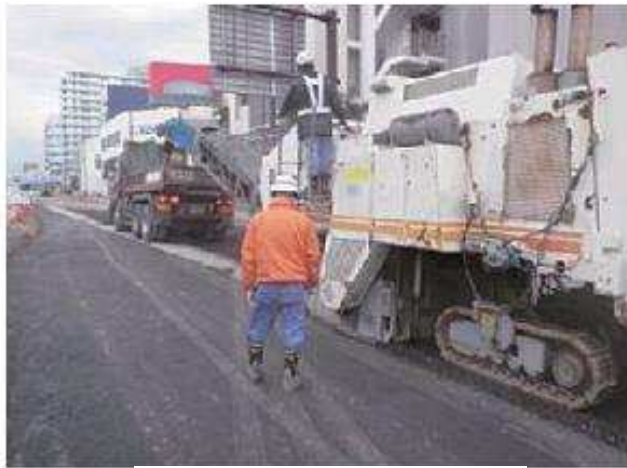
舗装路面の切削工事
