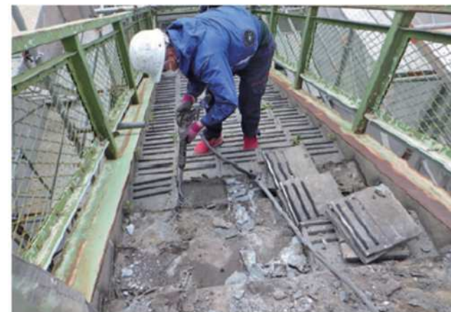
歩道橋階段補修工事
