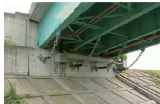
橋脚のチェーンによる落橋防止工
