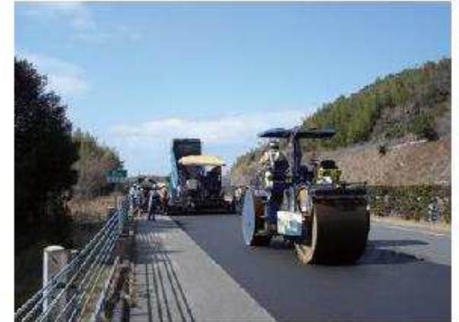
ロードローラによる舗装締固め工事
