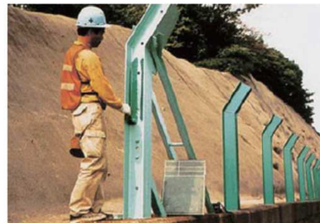
落石防止柵支柱の塗装工事
