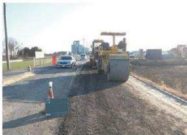
ロードローラによる道路路盤締固め工事
