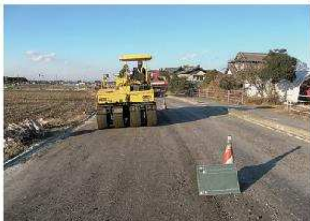
タイヤローラによる道路路盤締固め工事
