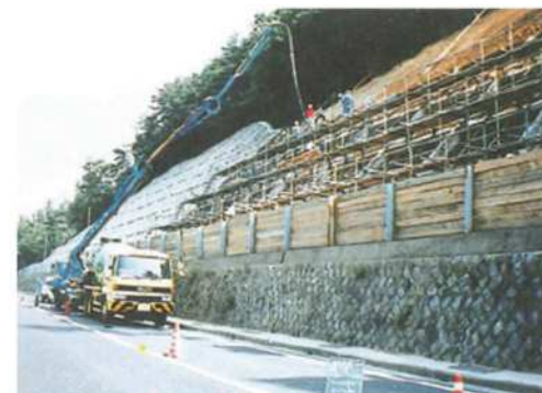
③コンクリート打設作業
