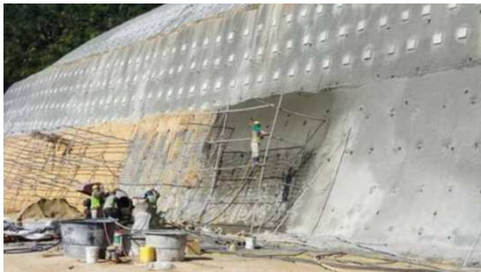
モルタル・コンクリートの吹付作業
