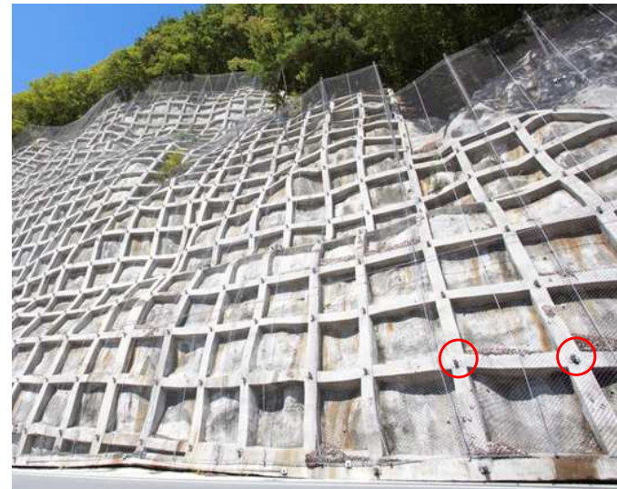
現場打ちコンクリート枠+グランドアンカー工
