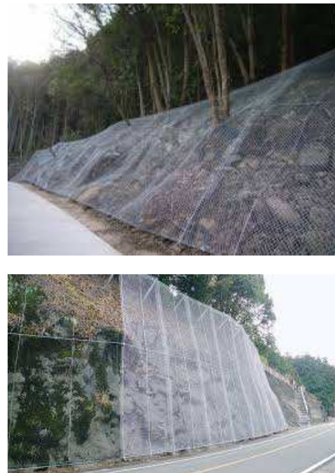
図3 法面防護工(ネット工)
