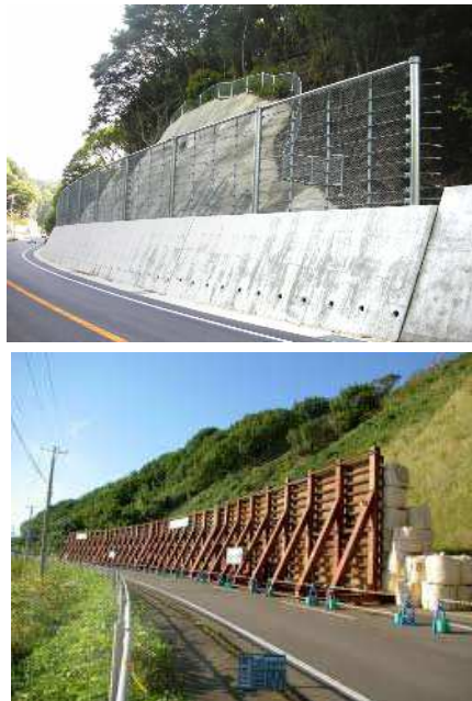
図2 落石防止壁
