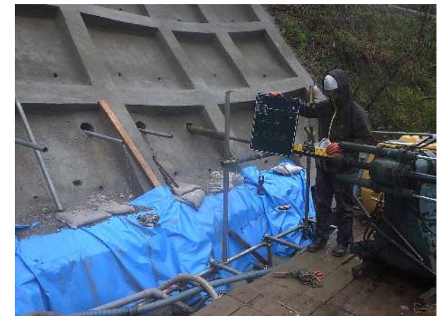
法面水抜きボーリング工
