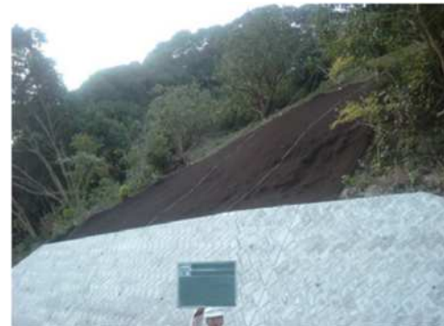
植生基材吹付完了法面
