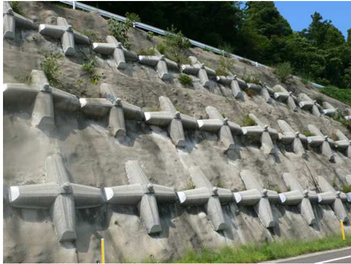
コンクリート吹付+グランドアンカー工
