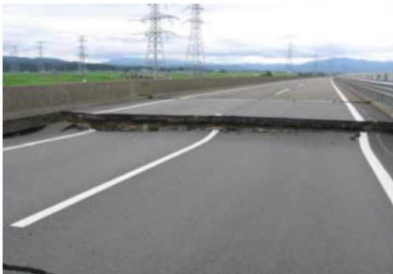
図-1 中越沖地震で発生した路面段差 1)
