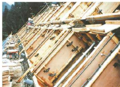
②型枠設置作業
