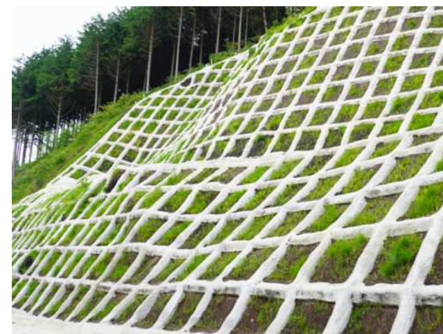
現場打ちコンクリート枠工+緑化植生工
