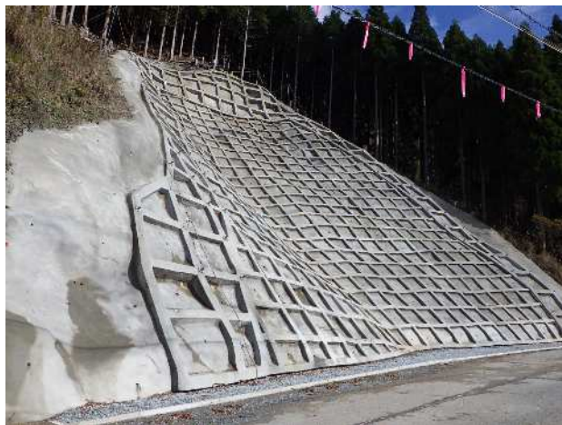
現場打ちコンクリート枠工+吹付工
