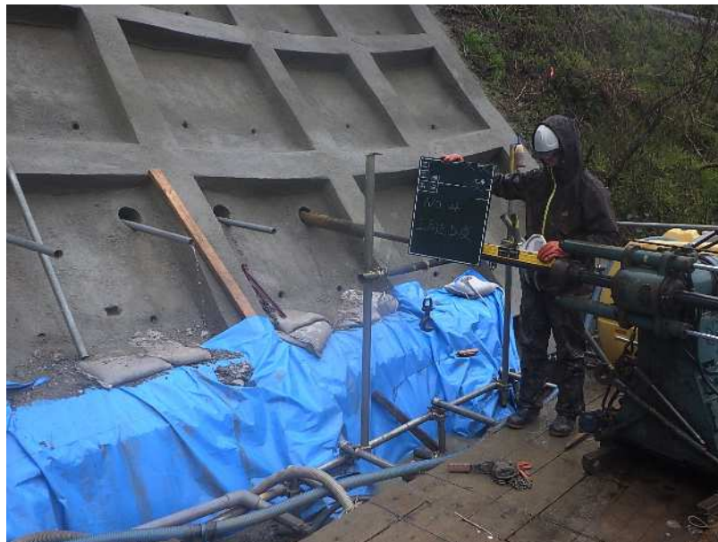
水平集水ボーリング法面内の水抜き
