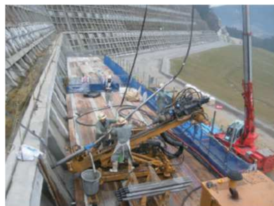
①削孔作業状況
