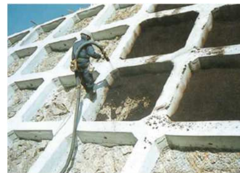
④中詰め工:厚層基材吹付作業
