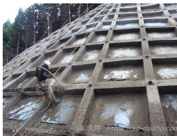
現場打ちコンクリート枠工+吹付工 +アンカー工
