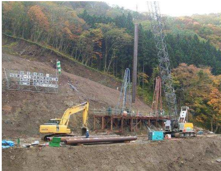
鋼管杭による法面滑り抑止杭打込み01
