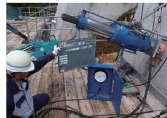
④定着材、アンカー緊張作業状況
