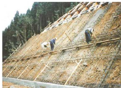
①鉄筋組立作業
