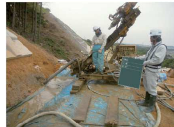
③グラウト材注入作業状況
