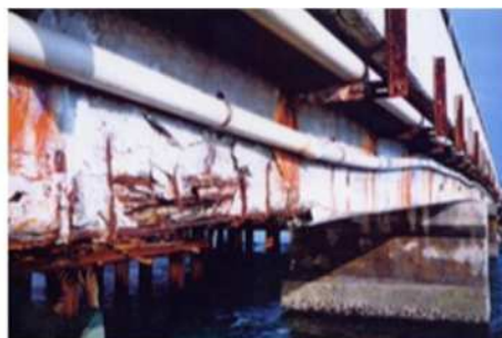
海上橋の腐食状況
