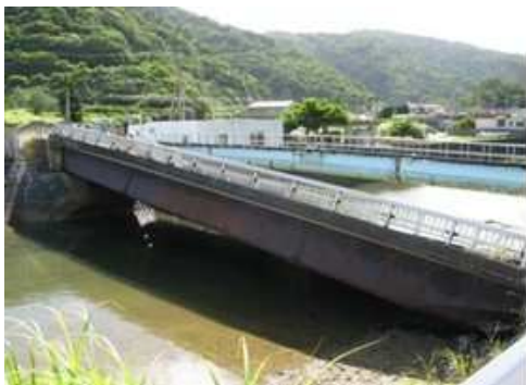
老朽化による落橋
