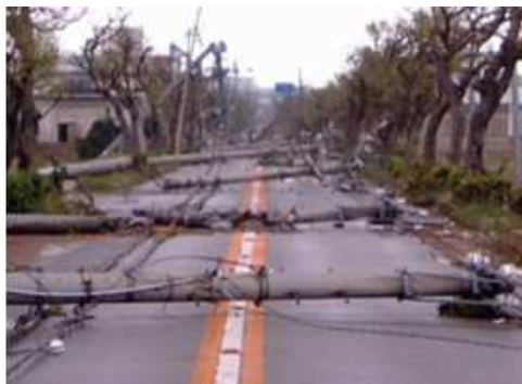
台風による電柱倒壊
