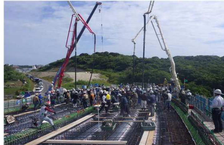
7-5-4 Concrete pouring
