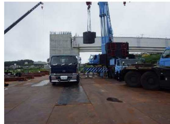
550t吊クレーン解体
