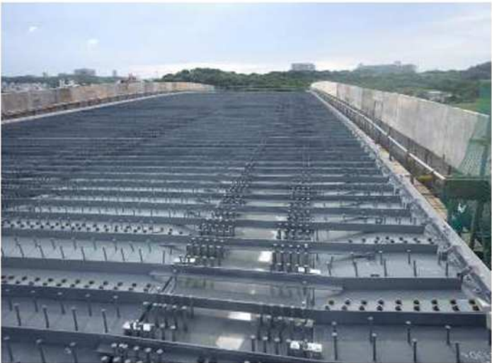
合成床版架設完了
