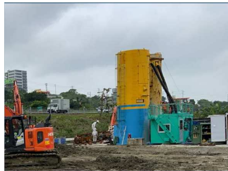
地盤改良プラント設置完了
