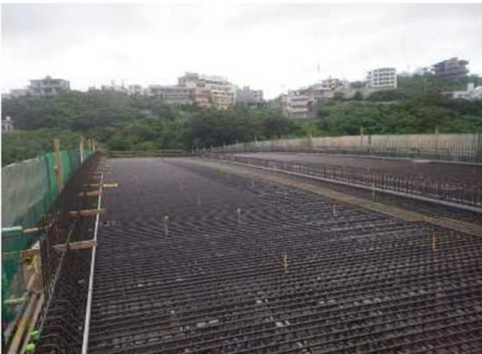
鉄筋組立完了
