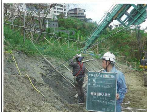
1-4 補強筋挿入状況
