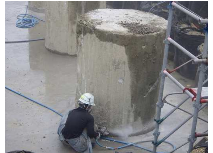
杭頭処理施工
