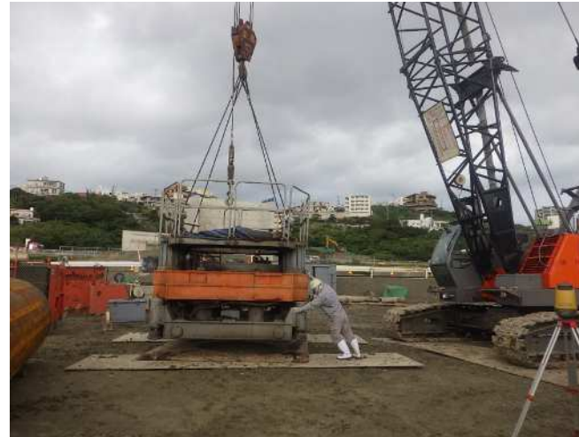
掘削機械設置（全回転機設置）
