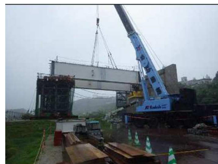
地組桁架設（160tクレーン）ベント～A2間
