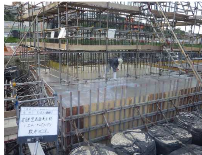
底版コンクリート打設 完了
