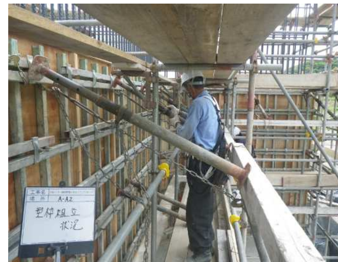
縦壁型枠組立（1ロット目）
