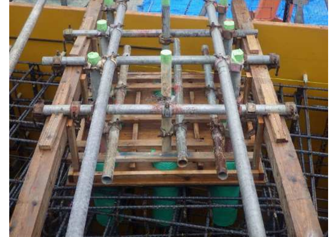
縦型枠組立 (3ロット目)
