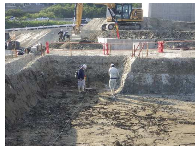
磁気探査 (経層探査)
