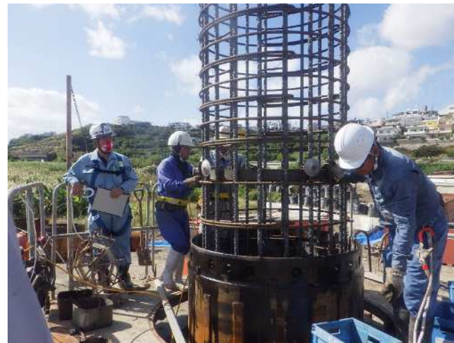
鉄筋かご建込み スペーサー設置
