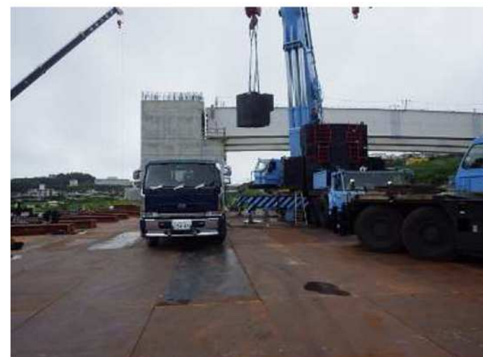
550t吊クレーン解体
