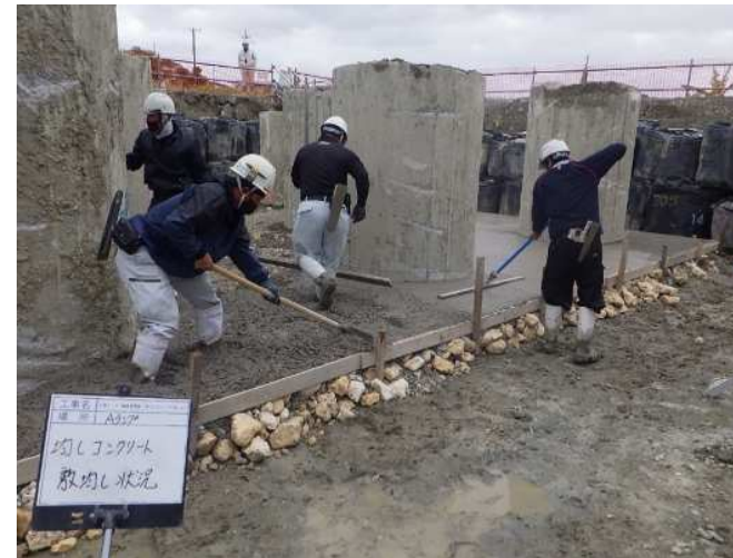
均しコンクリート打設
