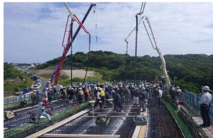
7-5-4 コンクリート打設工
