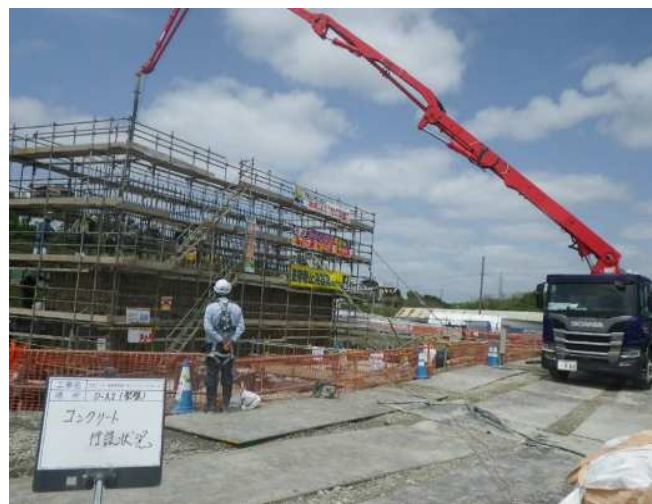
コンクリート打設（1ロット目）
