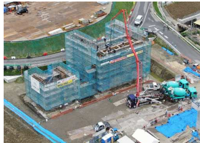
縦壁コンクリート打設 (3ロット目)
