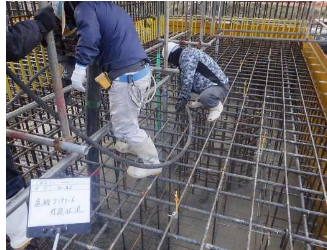
底版コンクリート打設
