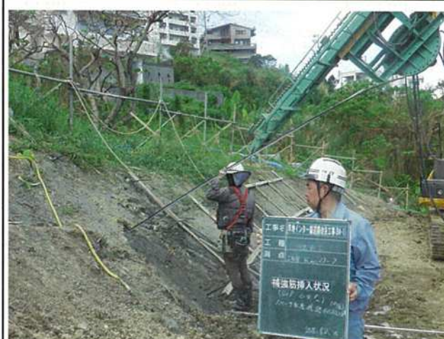
1-4 補強筋挿入状況
