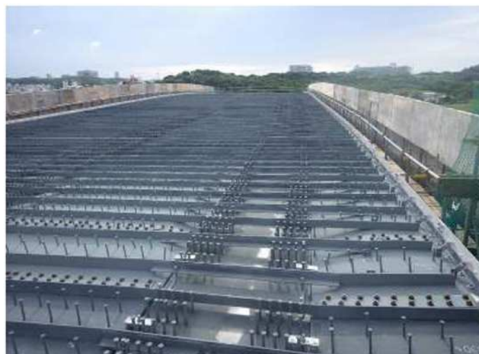
合成床版架設完了
