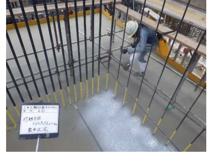
コンクリート養生材散布
