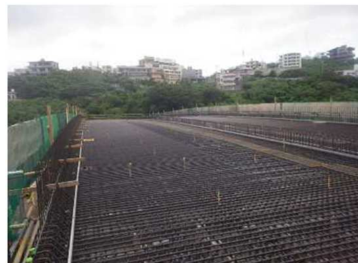
鉄筋組立完了
