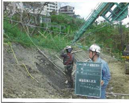
1-4 補強筋挿入状況
