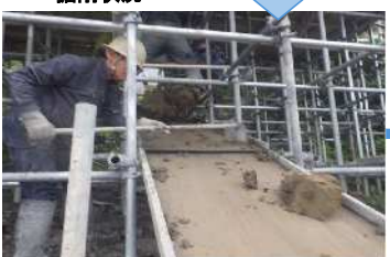
作業土工(土砂搬出)
