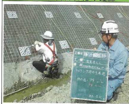
1-8 トルクレンチ締付け確認
