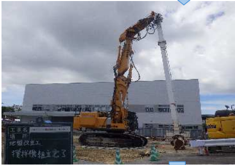
地盤改良機組立完了
