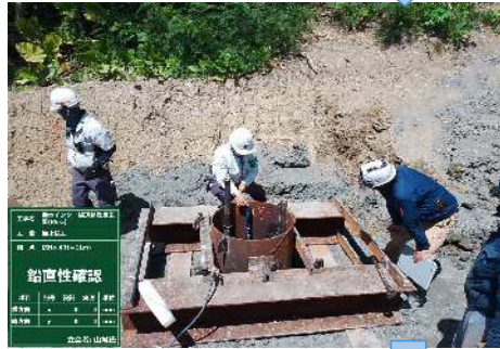
鋼管杭鉛直性確認
