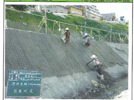
1-6 植生シート・溶接金網設置
