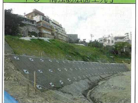
1-9 補強筋法面工完了
