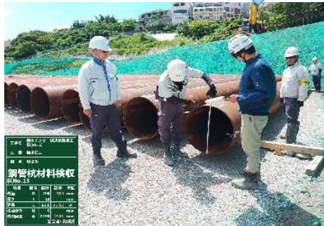
鋼管杭材料検収
