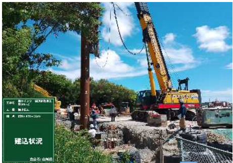
鋼管杭建込状況
