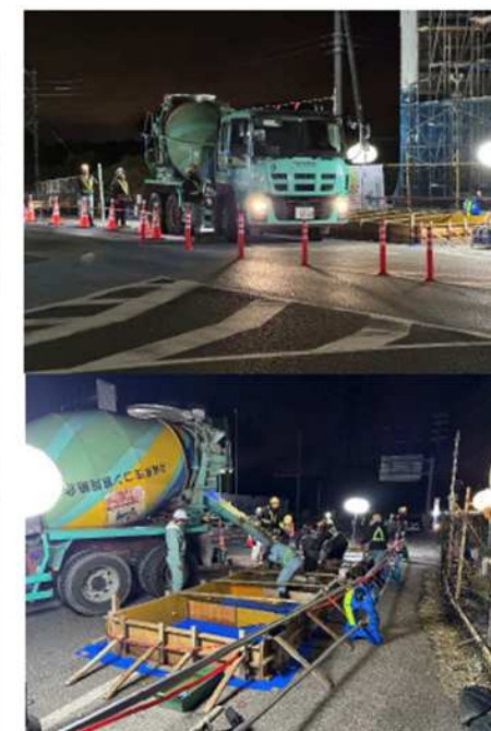
コンクリートミキサー車による コンクリート打設作業
