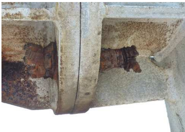
ボルト・ナットの破断
