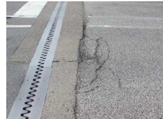
橋台背面の舗装ひびわれの例
