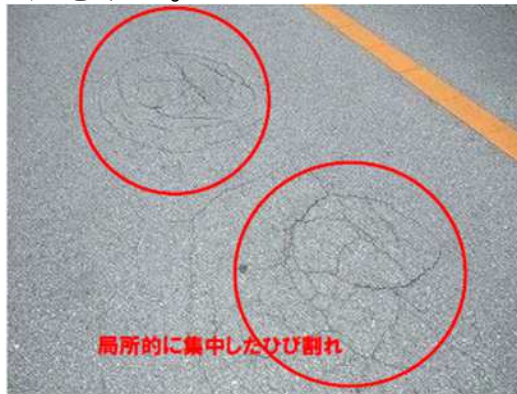
舗装面の注意すべきひびわれの例
