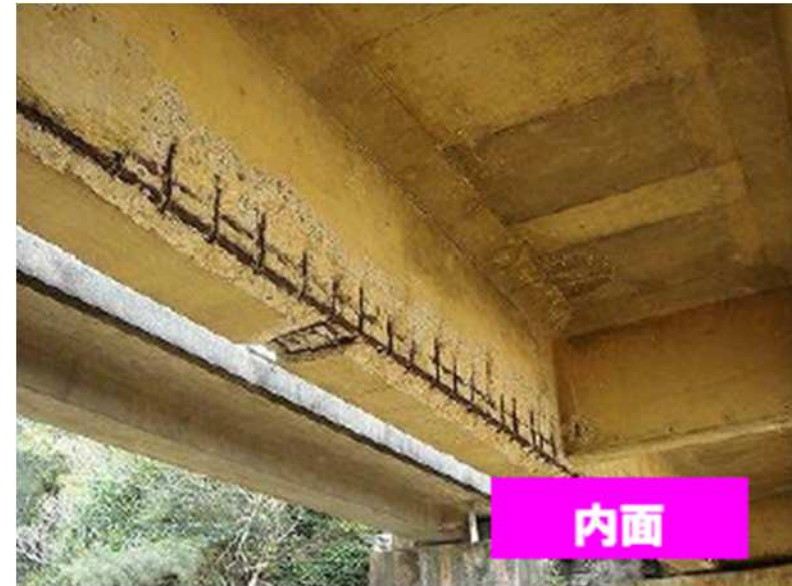
外桁の外面と内面の損傷度合いの違いの例
