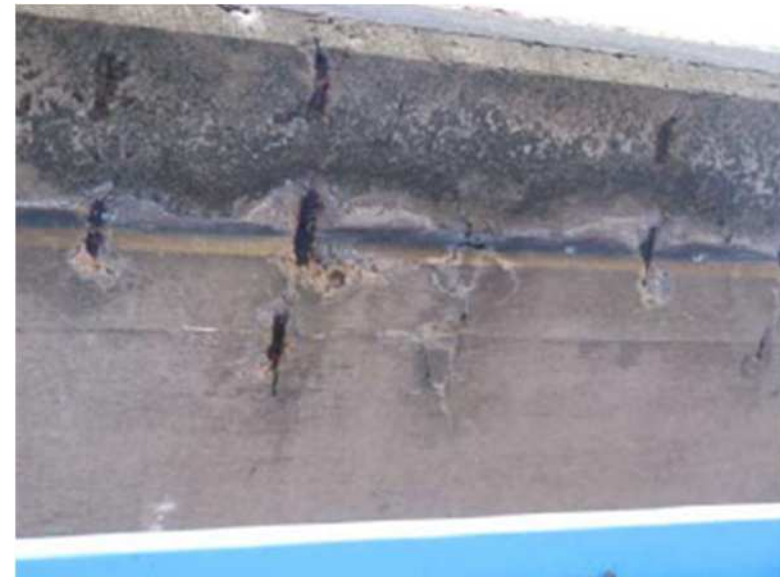
かぶり不足による鉄筋露出
