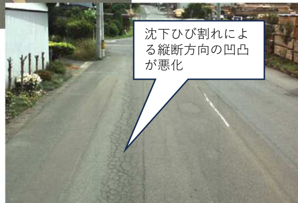
沈下ひび割れによる縦断方向の凹凸
