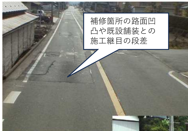
補修箇所の路面による縦断方向の凹凸
