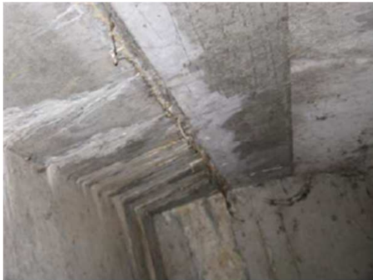
床版打継目からの遊離石灰の流出・漏出
