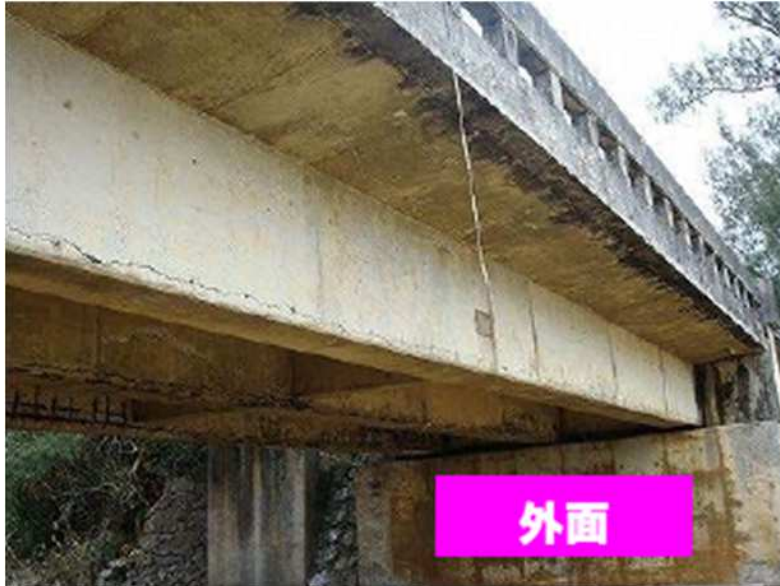
外桁の外面と内面の損傷度合いの違いの例
