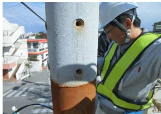
支柱継手部のボルト脱落
