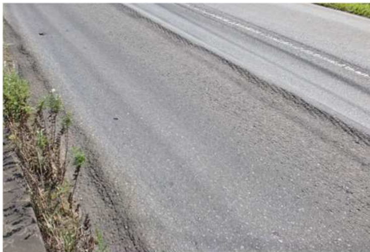
路床・路盤の圧縮変形によるわだち掘れの例
