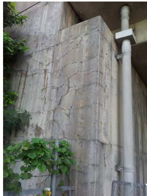
反応性骨材使用
