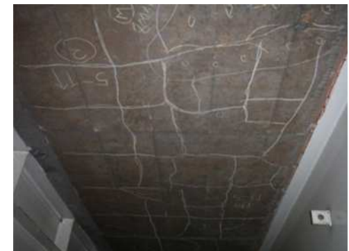
疲労による床版下面のひび割れ
